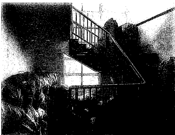
图 1 楼梯堆放杂物，堵塞疏散楼梯
